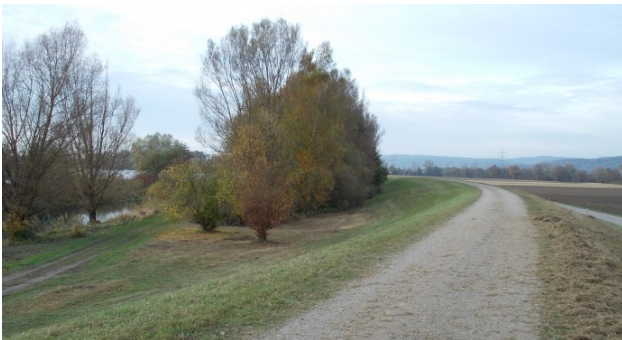
Auf die Damkrone verlegter Donauradweg bei Kirchroth
