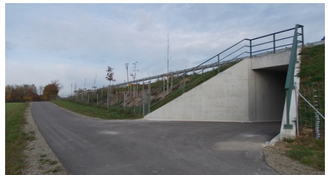
Radwegeverbindung Steinach-Agendorf mit neuer Unterführung B 20, gleichzeitig Teil des „Kinsachtal-Radwanderweges“ und des „3-Bäche-Rundweges“
